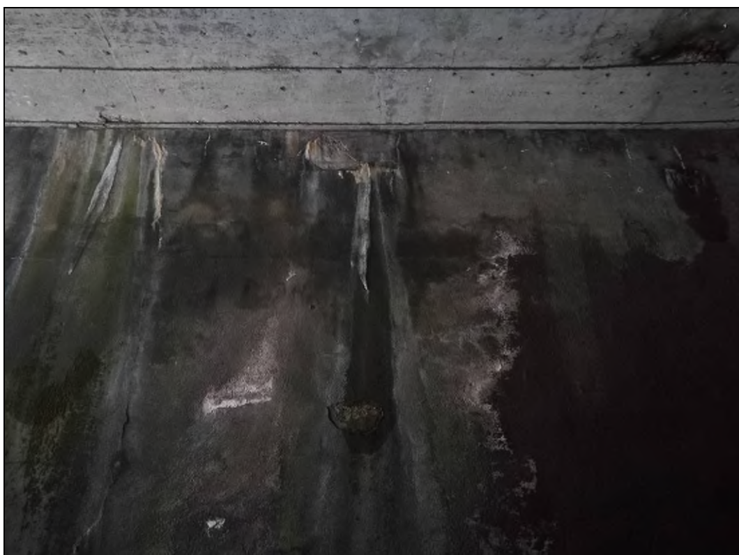
Obr. č. 6 - pohled na trhliny s průsaky ve spodní stavbě
