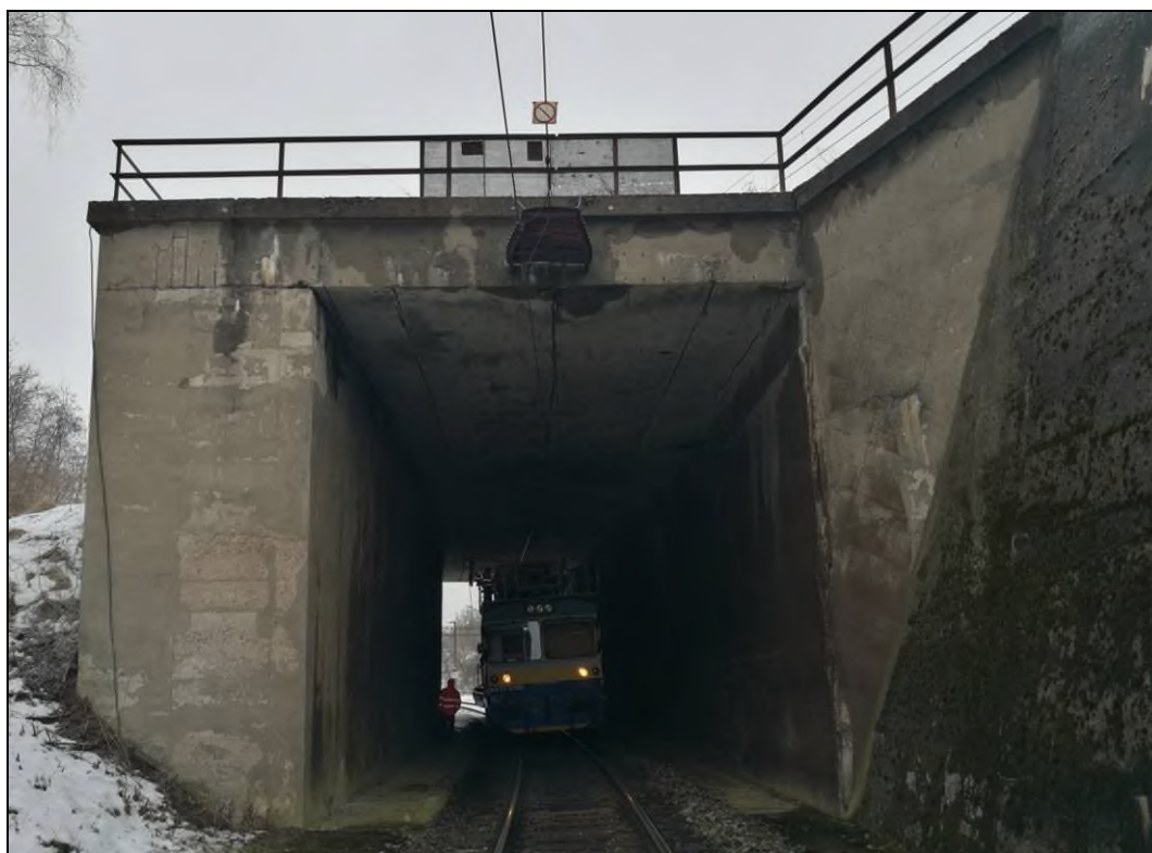
Obr. č. 3 - pohled na opady omítky v čele objektu
