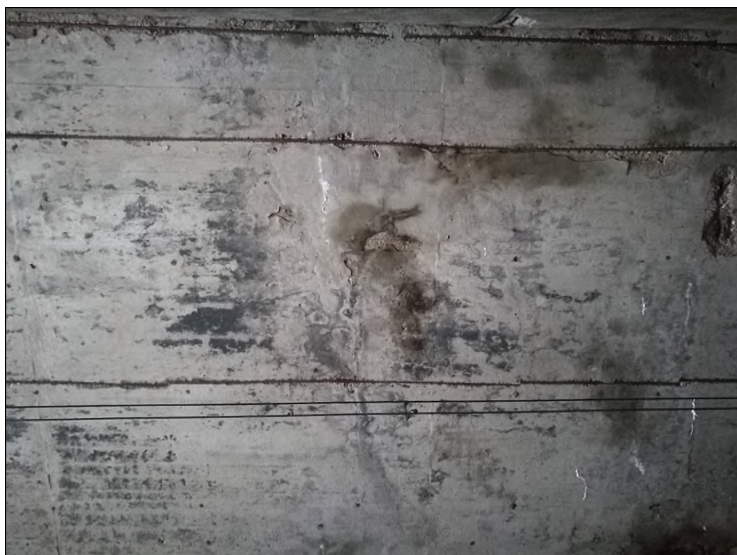
Obr. č. 4 - pohled na spodní líc NK s opady a vlasovými trhlinami
