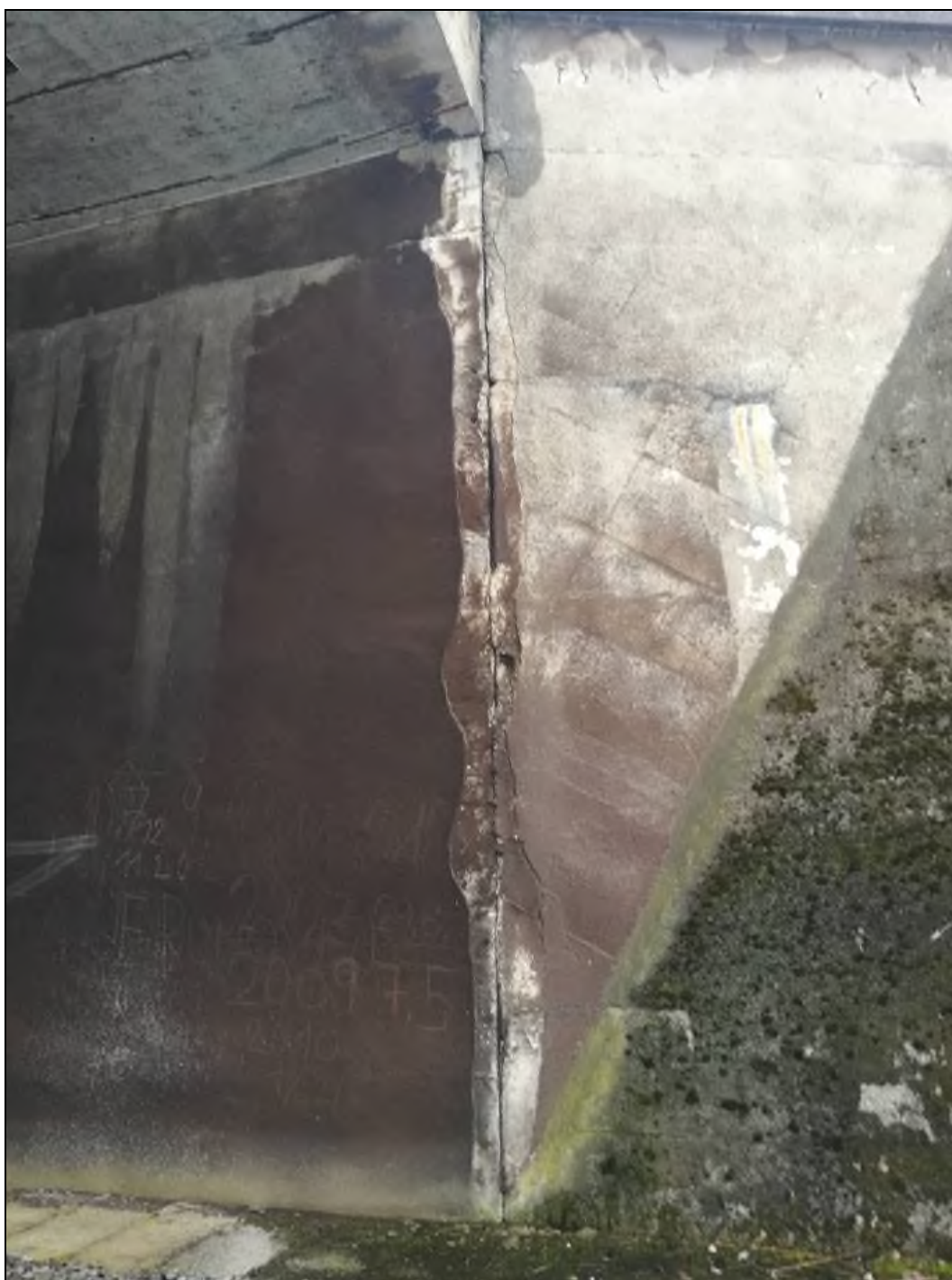
Obr. č. 10 - pohled na napojení šikmého křídla k objektu, opady omítky podél dilatační spár
