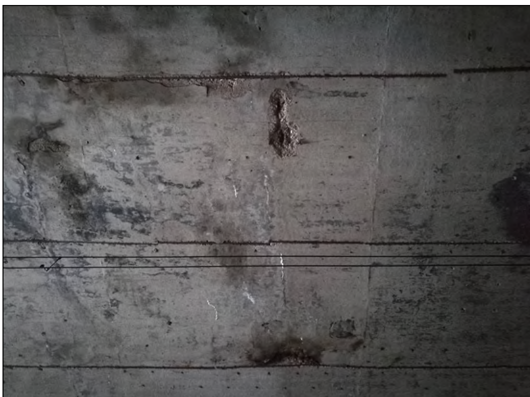
Obr. č. 5 - pohled na spodní líc NK - v líci viditelná rozdělovací výztuž
