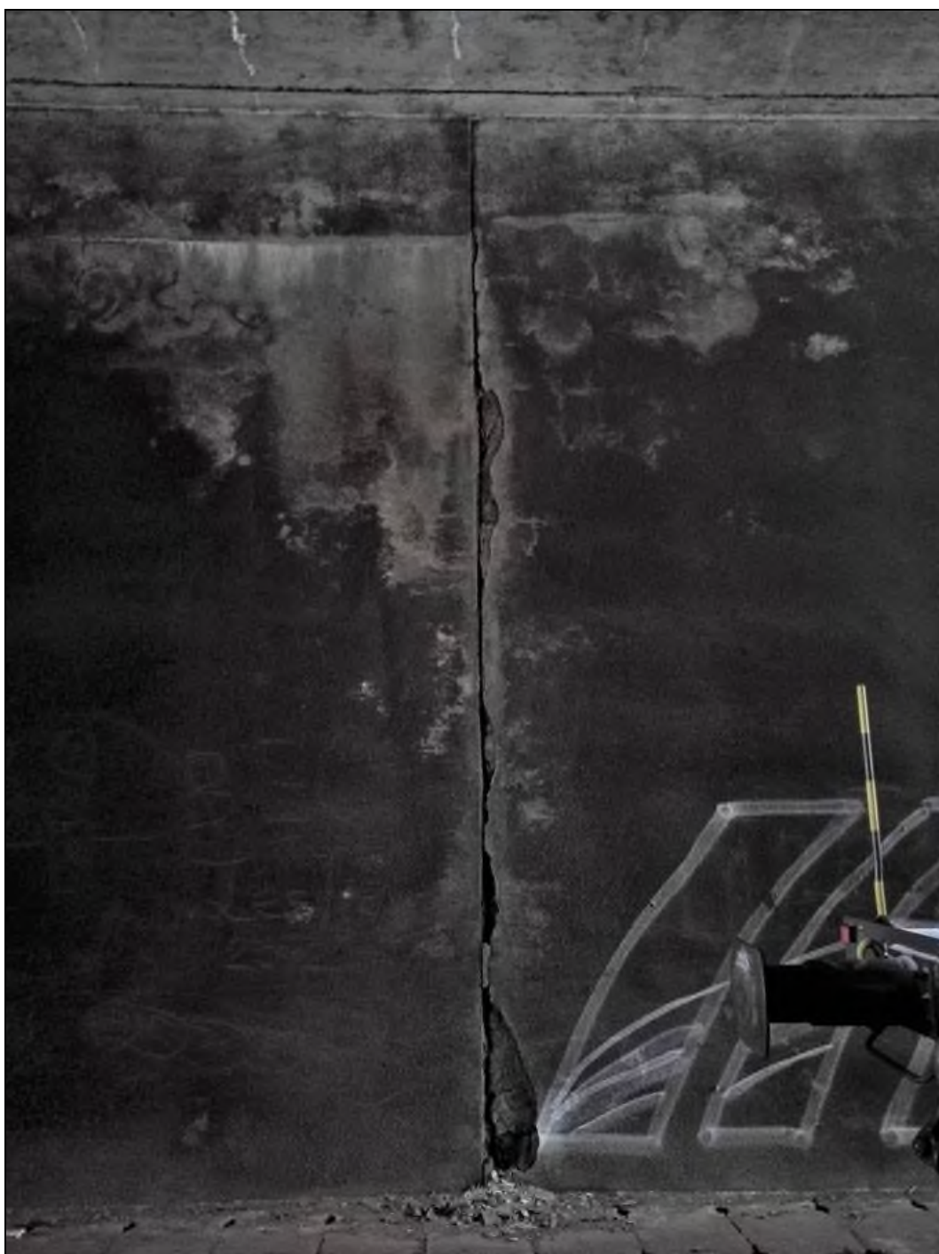
Obr. č. 7 - pohled na opady omítky a betonu v okolí dilatační spáry
